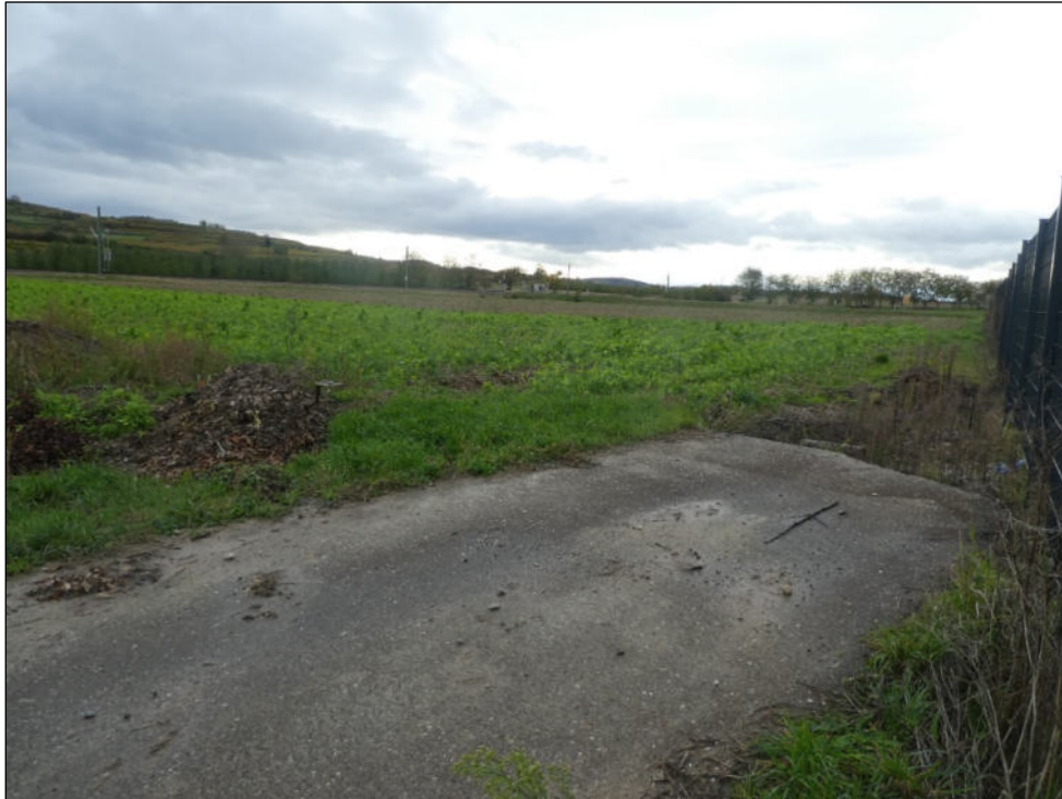
Foto 4: Vorhandener Rest des ehem. Wirtschaftswegs, mit kieshaltigem Untergrund und lückiger Ruderalvegetation.
